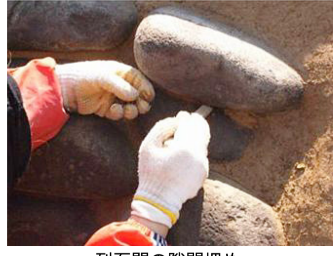
列石間の隙間埋め
